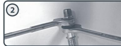
3 | Coloque a porca do adaptador na entrada de gás. Em seguida, encaixe o adaptador e rosqueie a porca de fixação. Utilize duas chaves de boca para auxiliar o aperto.
