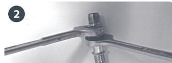
3. Coloque a porca do adaptador na entrada de gás. Em seguida, encaixe o adaptador e rosqueie a porca de fixação. Utilize duas chaves de boca para auxiliar o aperto.
